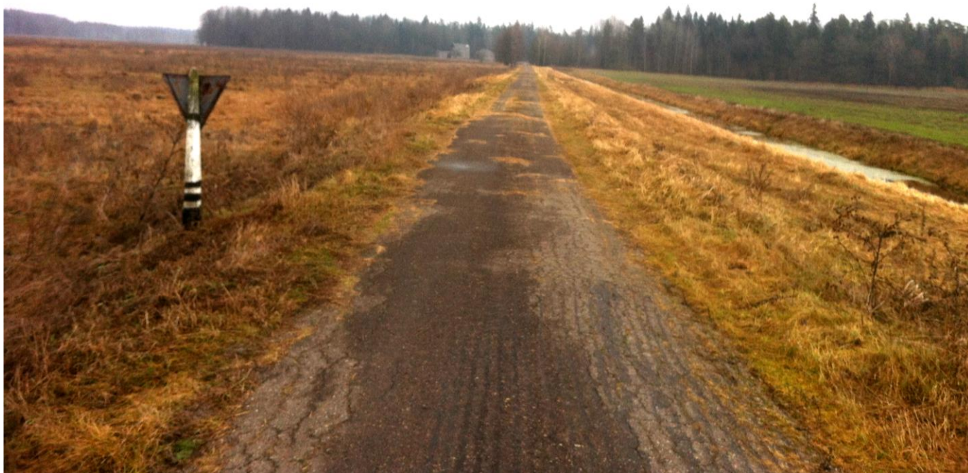
Рис.4 Подъездная дорога к хозяйственной зоне на территории объекта
