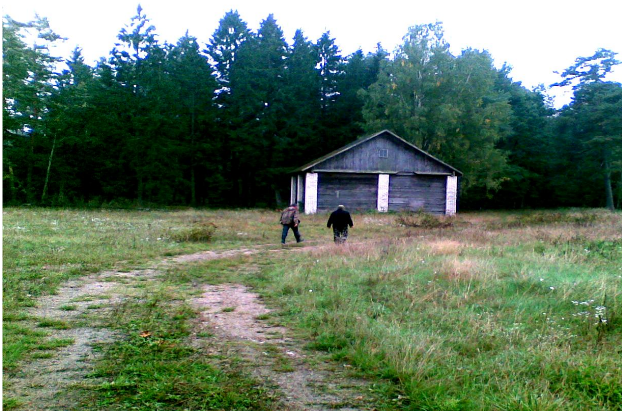
Рис.6 Действующий хозяйственное здание. Грунтовая дорога на территории объекта
